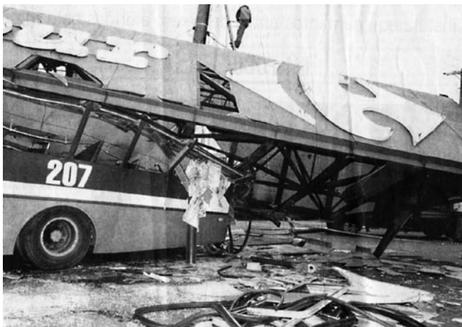
Figura 11 - Desabamento das torres metálicas de sustentação de um painel de propaganda em Osasco/São Paulo
